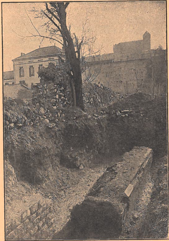
PLATE-FORME D'UN TROPHÉE (Chantier Baron).
