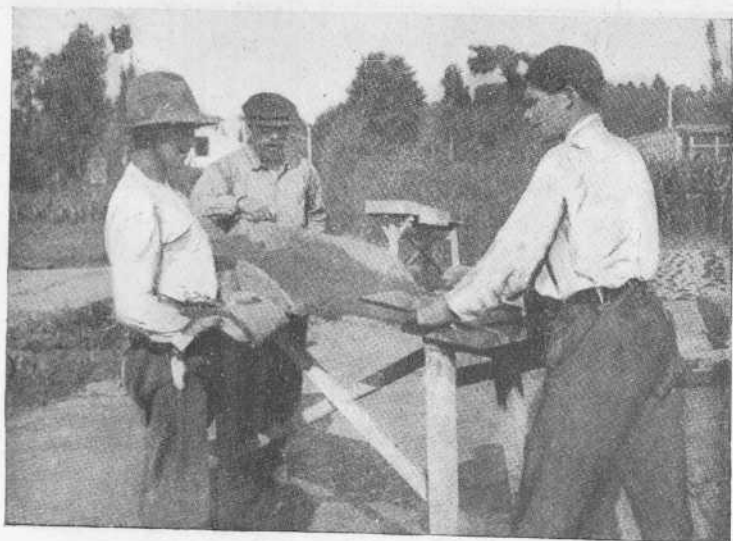
Fig. 32. Moldeado de tejas.
